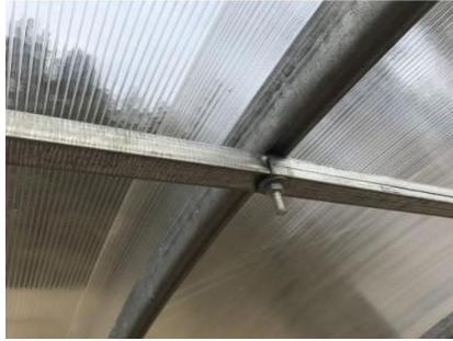
Pav. 10 Templių ir lankų sujungimas
