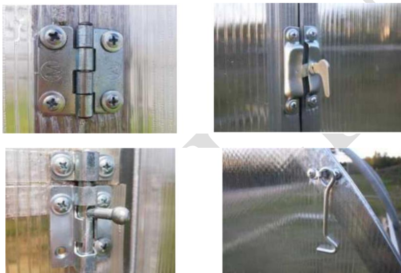
Pav. 2.2 – Lankstų, suktuko, skląščio, kabliuko tvirtinimas
