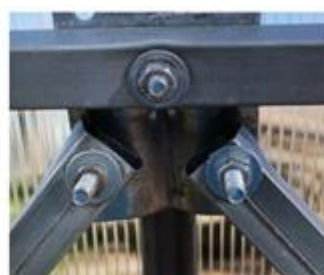
Pav. 3.2 – Šoninių įstrižainių tvirtinimas
