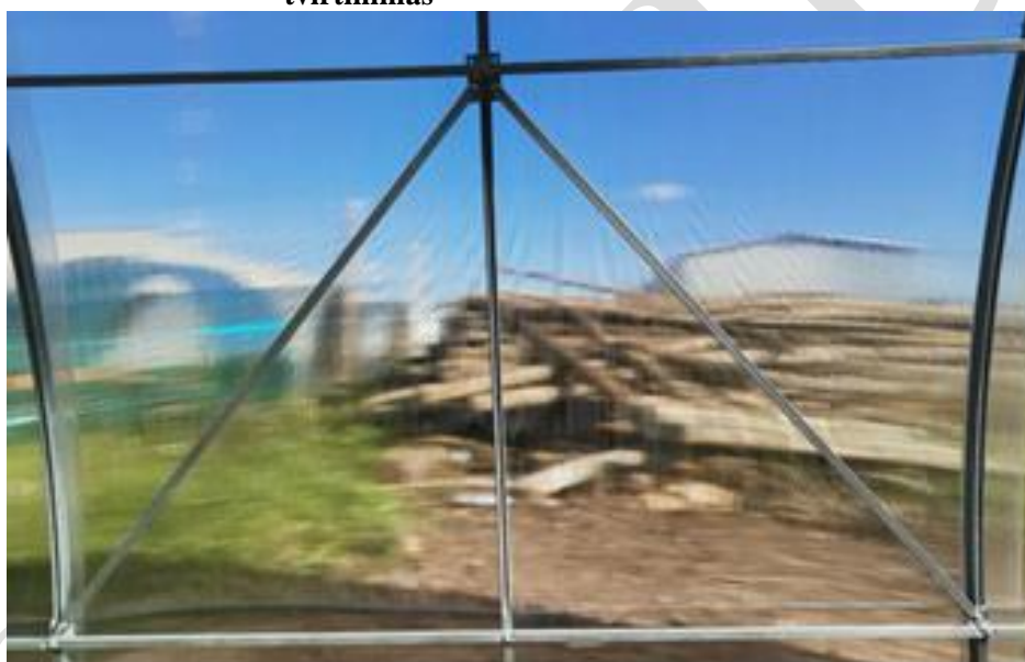
Pav. 3.3 Įstrižainių tvirtinimas
