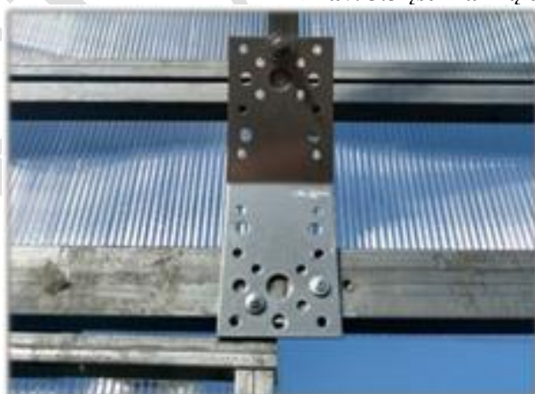
Pav. 3.4 – Viršutinės įstrižainės tvirtinimas
