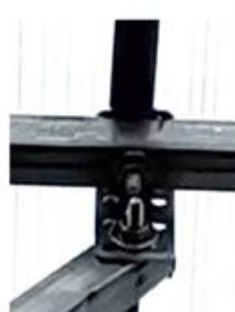
Pav. 3.4 – Viršutinės įstrižainės tvirtinimas
